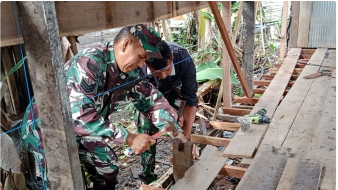
Bongkar Rumah Warga "Danramil Astambul Kini Tahap Pemasangan Lantai Kayu dan Dinding
